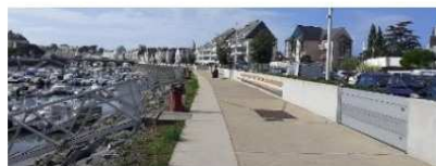
Protection des quais de l'étier du Pouliguen
