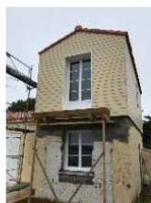
2 espaces refuges 6 poses de Velux
