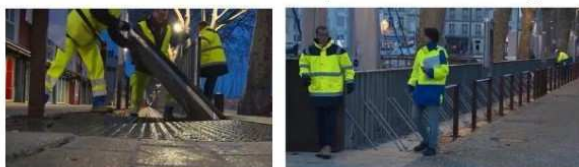
Protection des quais du Gabut à la Rochelle
